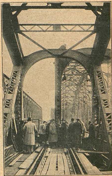
Der Einschub eines Tragwerkes.
