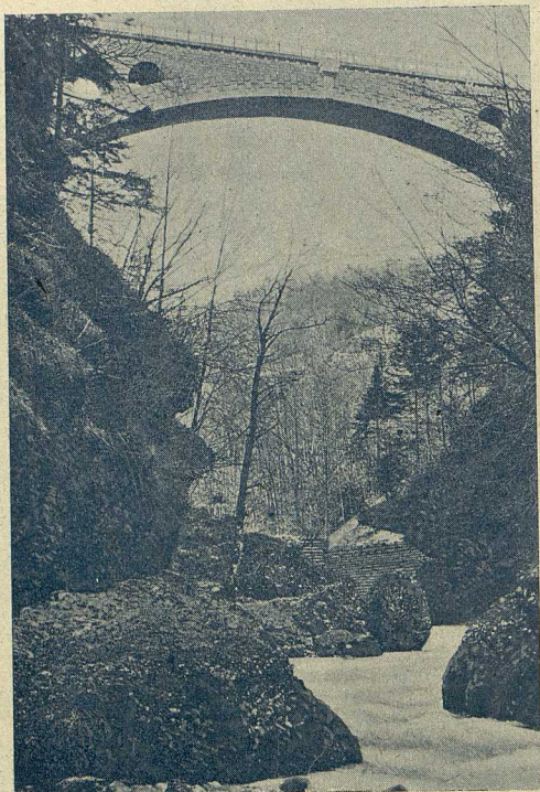
Bilder aus Oberösterreich: Steyringsbrücke der Pöhrnbahn.
