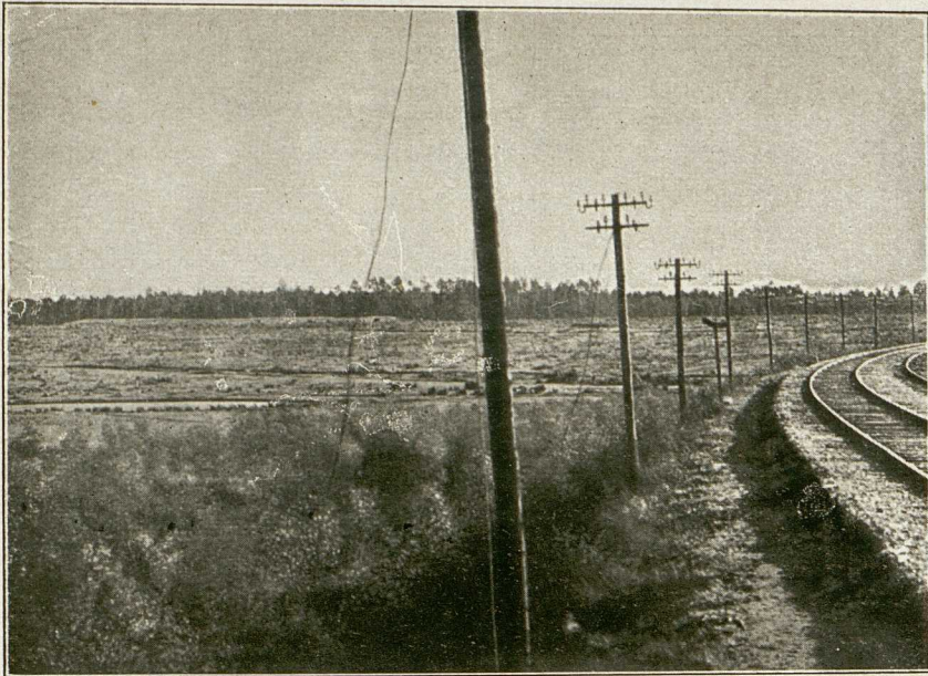
Blick von der Bahn auf Fort XVb.
