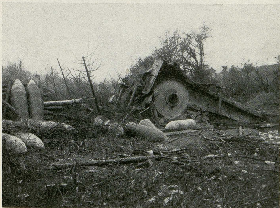
42-cm-Mörser, durch Rohrkrepierer zerstört
