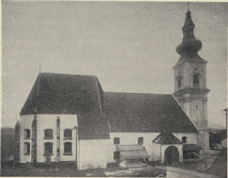
Die alte Pfarrkirche vor dem Abbruche i. J. 1900.
