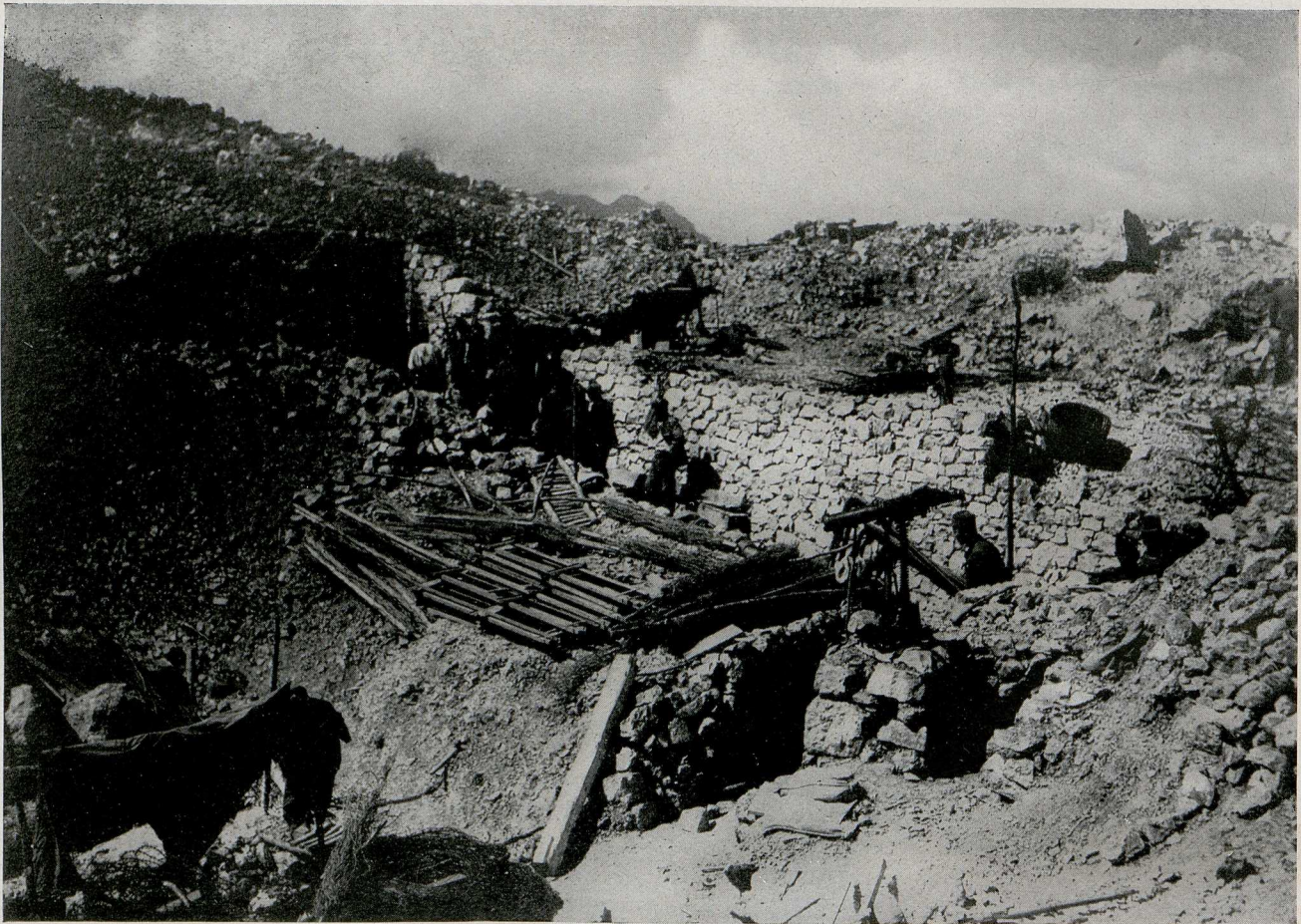
Teilansicht des ausgebauten Sprengtrichters
