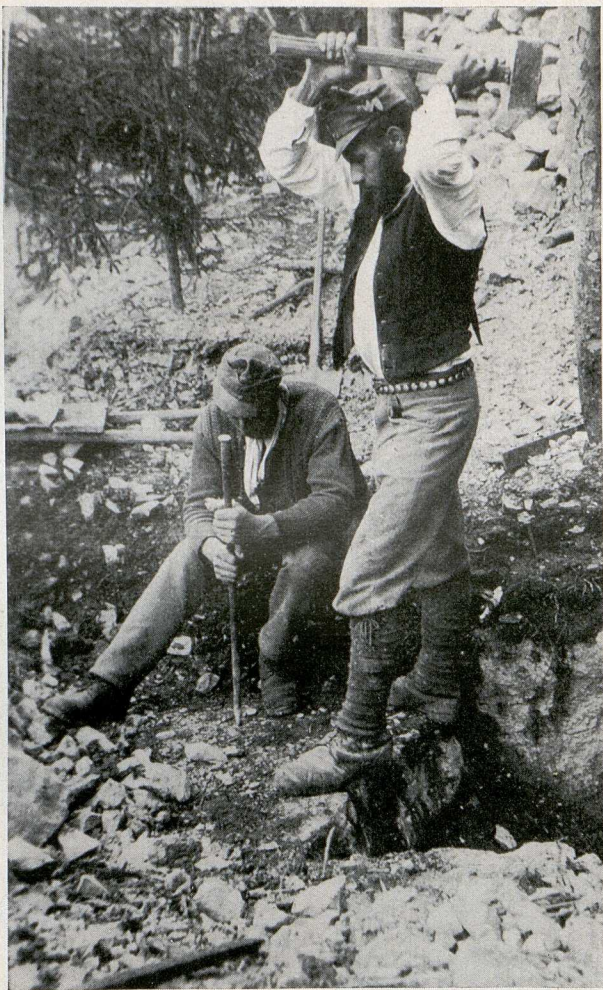
Rainer sprengen einen Laufgraben aus
