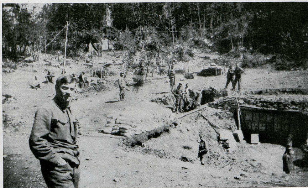
In einer flachen Mulde hinter der Hauptstellung der 5. Komp. waren ihre Deckungen erbaut
