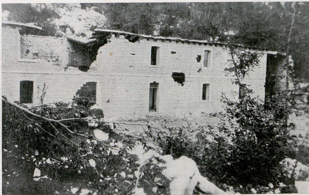
Die Bersaglieri-Kaserne befand sich etwa 1000 Schritte nördlich des Cimone-Gipfels, knapp südlich der Werkstraße, die in ihrer Fortsetzung über den steilen Westhang des Plateaus führt.
