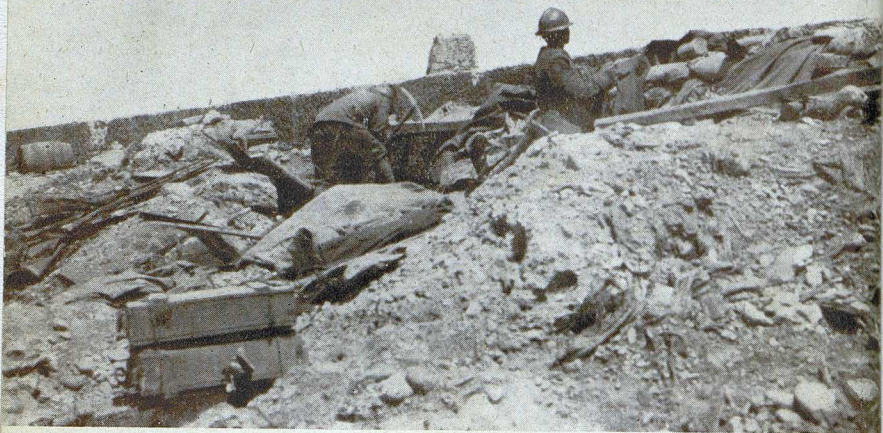
Italienische Betonstellung bei Asiago
