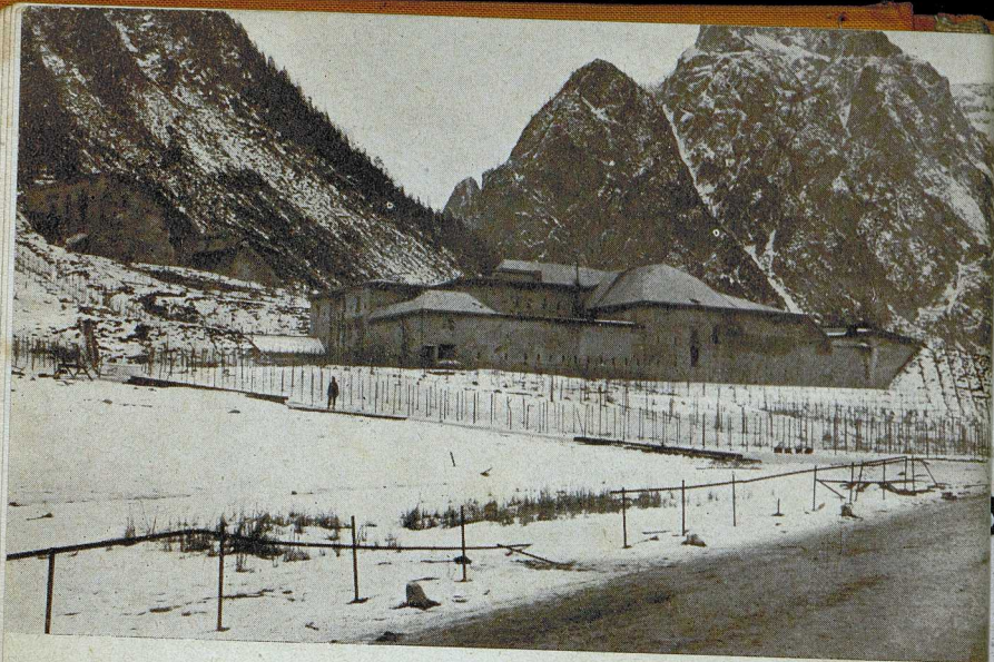
Sperre Landro, im Hintergrund Monte Piano
