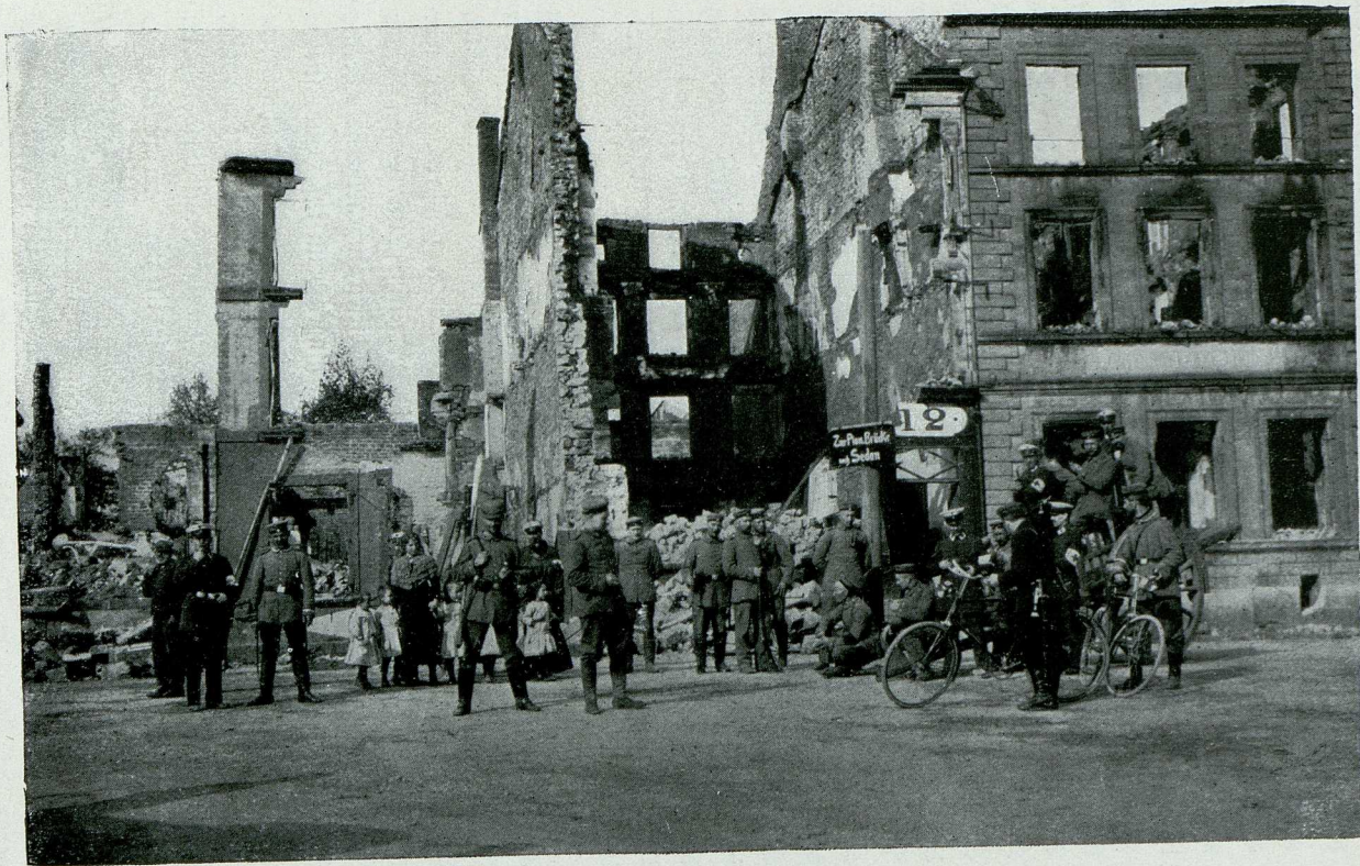
Zerschossene Häuser in Donchery.
