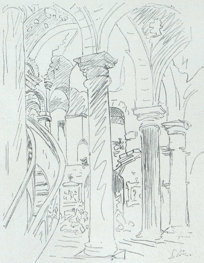
Die Kirche von Longwy mit durchschossenem Gewölbe und erhaltener Kanzel.
