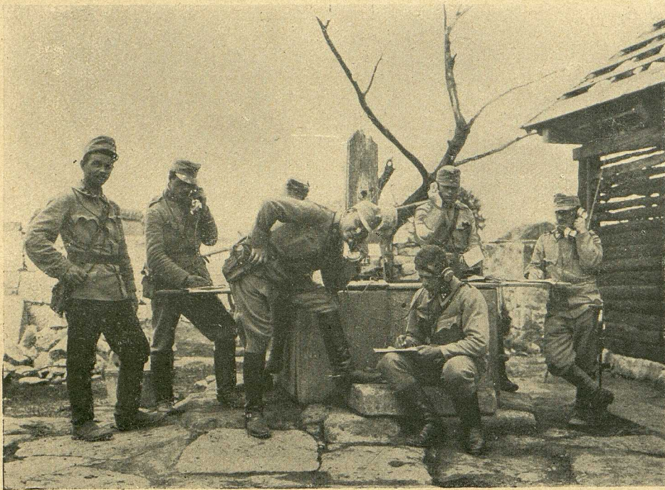
Telephonzentrale im Felde.
