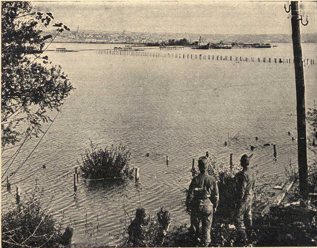
Die Kriegsbrücke Zemun—Belgrad im Bau.
