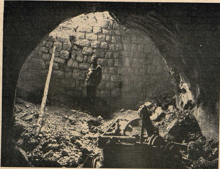
Geschosfeinschlag im Maschinenhaus des Werkes Monte Verena.
