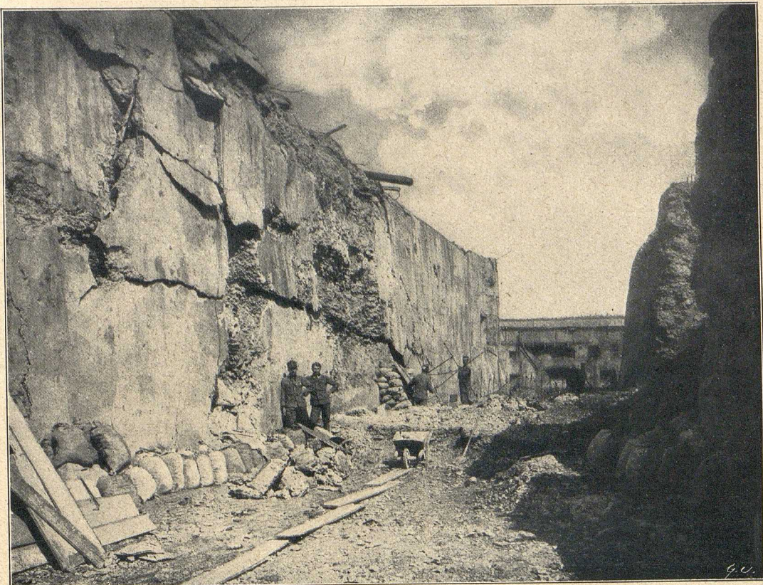
Graben des Werkes Luserna nach wiederholter Beschießung.
