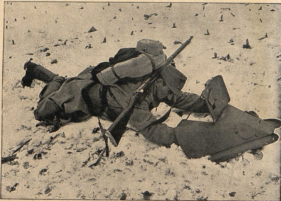
Schild, beim Durchschneiden des Drahtverhaues verwendet.
