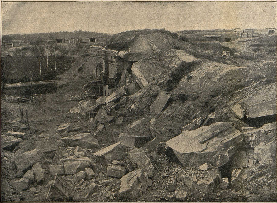
Die Trümmerhaufen der Kasematten in der Festung Dsowiec, die von den Russen vor ihrem Abzug gesprengt wurden.
