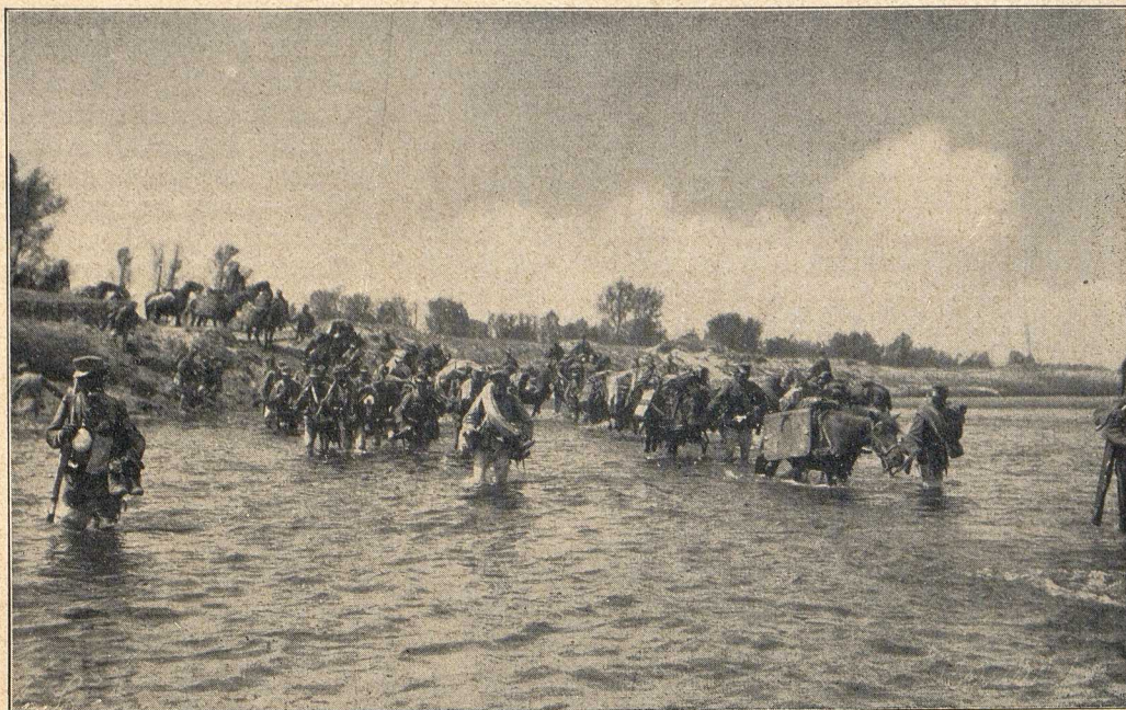
Übergang über den Sanew.
