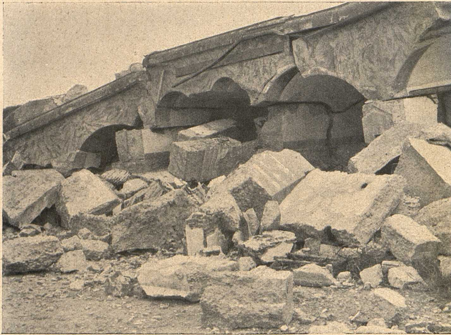
Trümmer des von uns gesprengten Werkes XIII.
