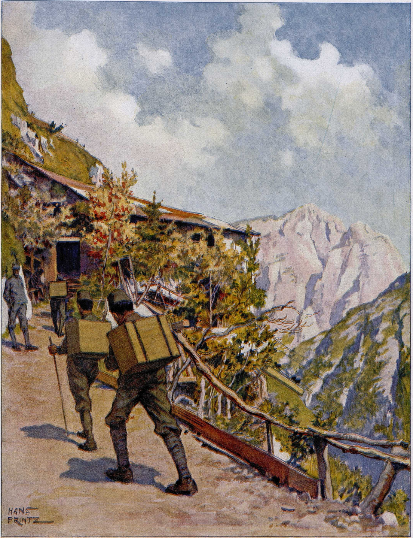
Seilbahnstation am Kombohang. Von Hans Prinz.
