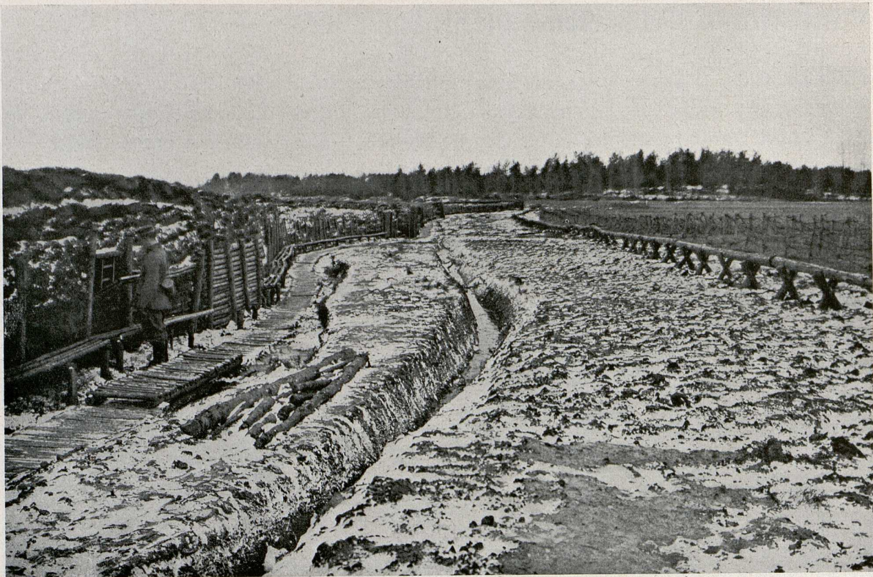
Auch außerhalb der Sumpfsgebiete mußten die Stellungen oft wegen des hohen Grundwasserstandes aufgesetzt werden.
