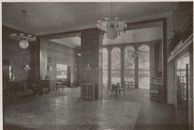
Blick vom Tanzplatz in den Garten. Schiebetüren
