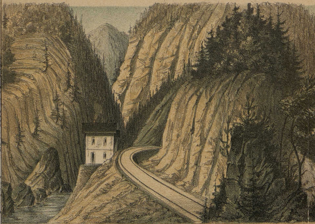
verschobenen Wände bei Wächterhaus N o 91.
