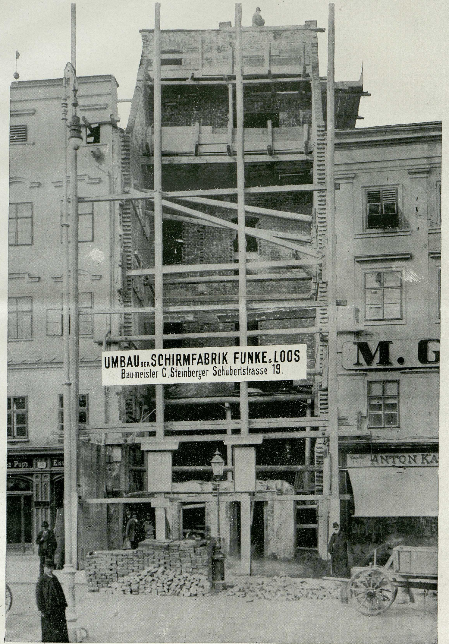
Baufortschritt des Vordertraktes.
