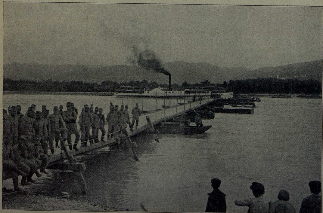
Oesterreichische Pioniere schlagen eine Kriegsbrücke über die Donau.
