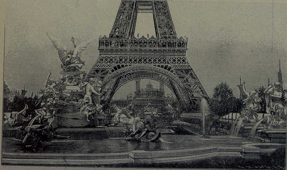
Der Eiffelturm in Paris, auf dem eine Funkstation angebracht ist.
