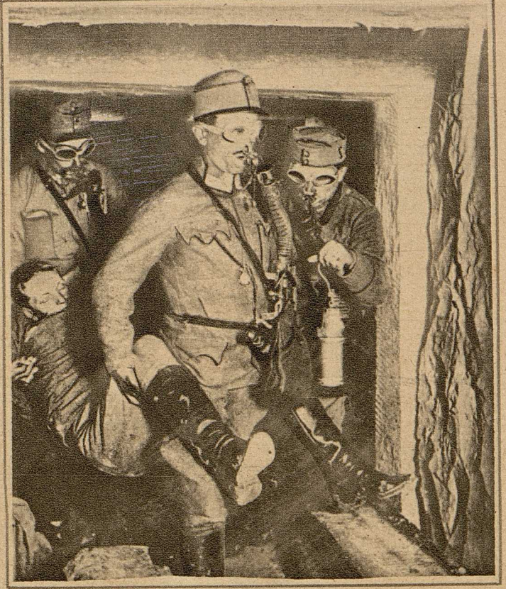
Der Minenkrieg. Ein Bewußtloser wird aus dem gaserfüllten Fuchslotz von Rettungsmannschaften mit Sauerstoffapparaten herausgetragen.
