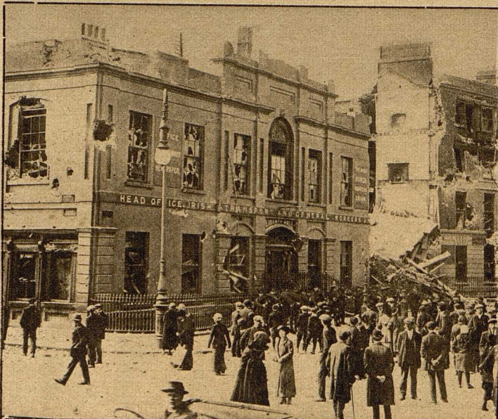
Die zerstörte Freiheitshalle in Dublin. (Die Einschlaglöcher in Wänden und Fenstern zeugen von der Heftigkeit der Beschiesung.)
