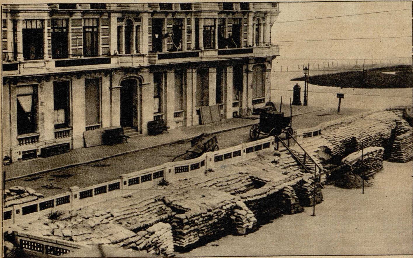
Aus Sandsäcken auf kräftigen Holzgestellen aufgebaute Unterstände deutscher Matrosen an einer Straße in einem flandrischen Orte. (Photobek.)
