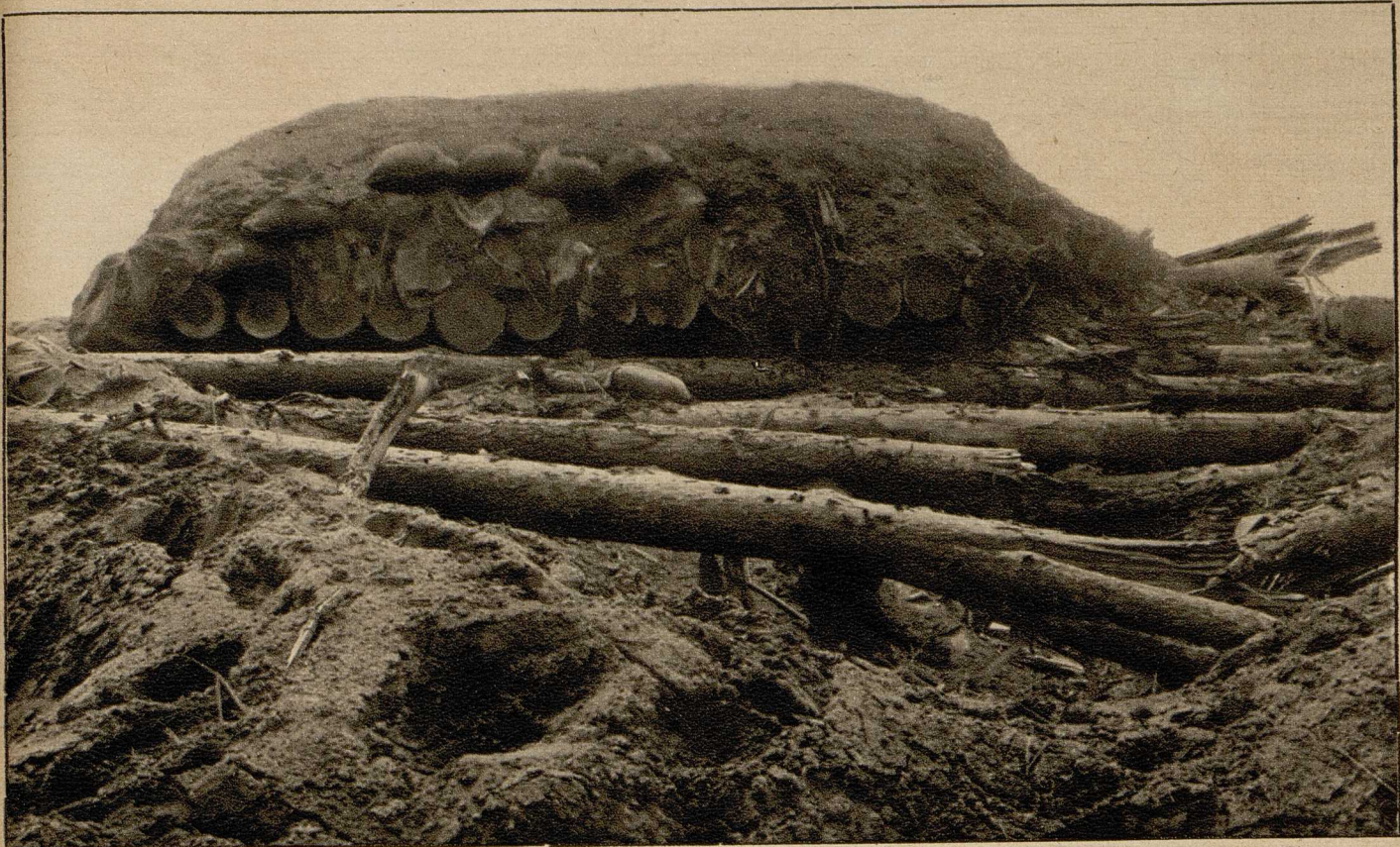
Halbunterirdische russische Nothütte, gut gegen Gewehrflugeln und kleinere Artilleriegeschosse mit Baumstämmen und Sandsäcken verkleidet. (Phot. Lamm.)
