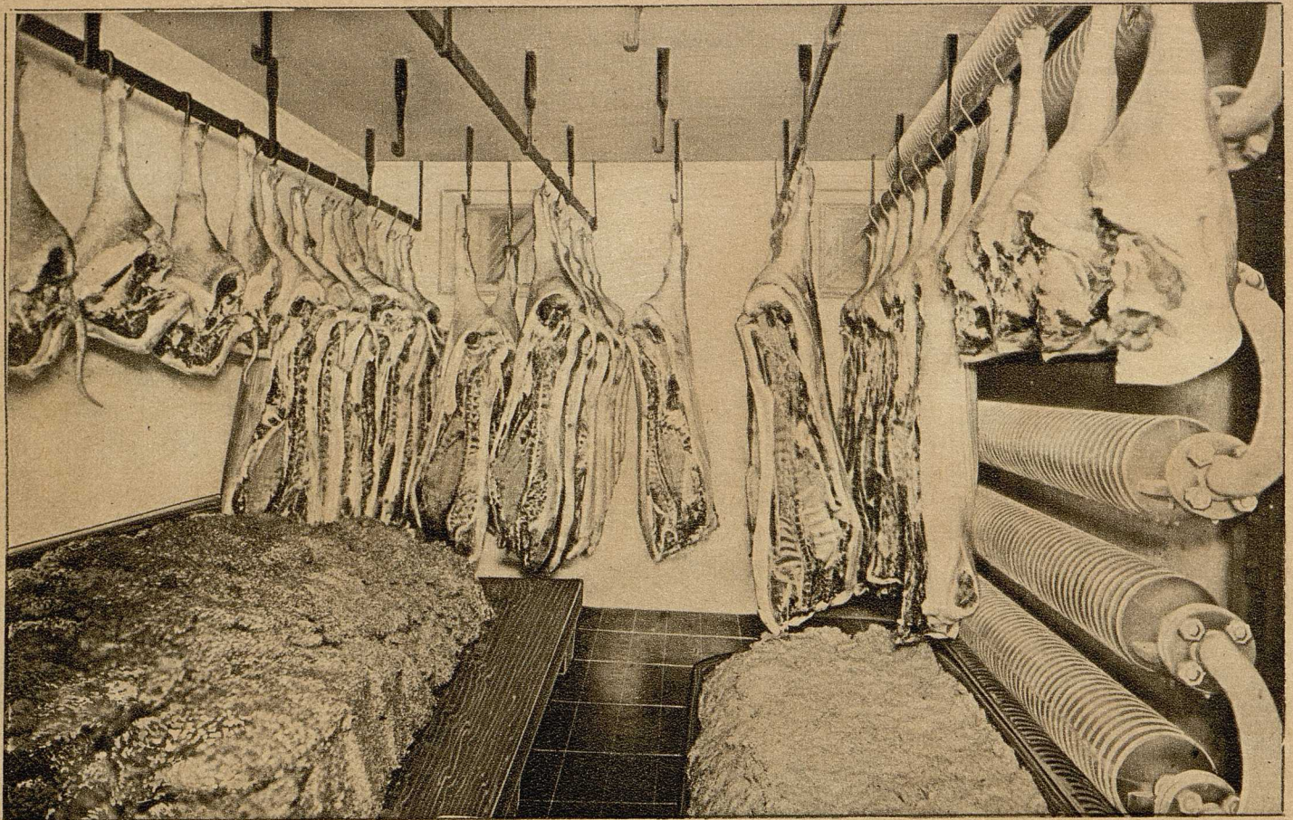
Kühlraum für Fleisch.
