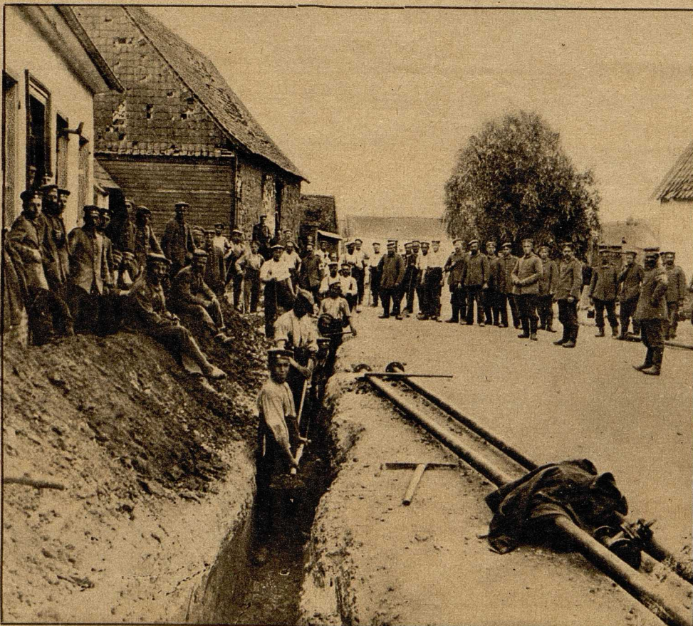
Arbeiten an den Anlagen einer Wasserleitung, die bis in die Schützengräben gehen soll und nur noch 300 Meter bis zu ihrer Vollendung braucht. (Ill. Photoverl.)
