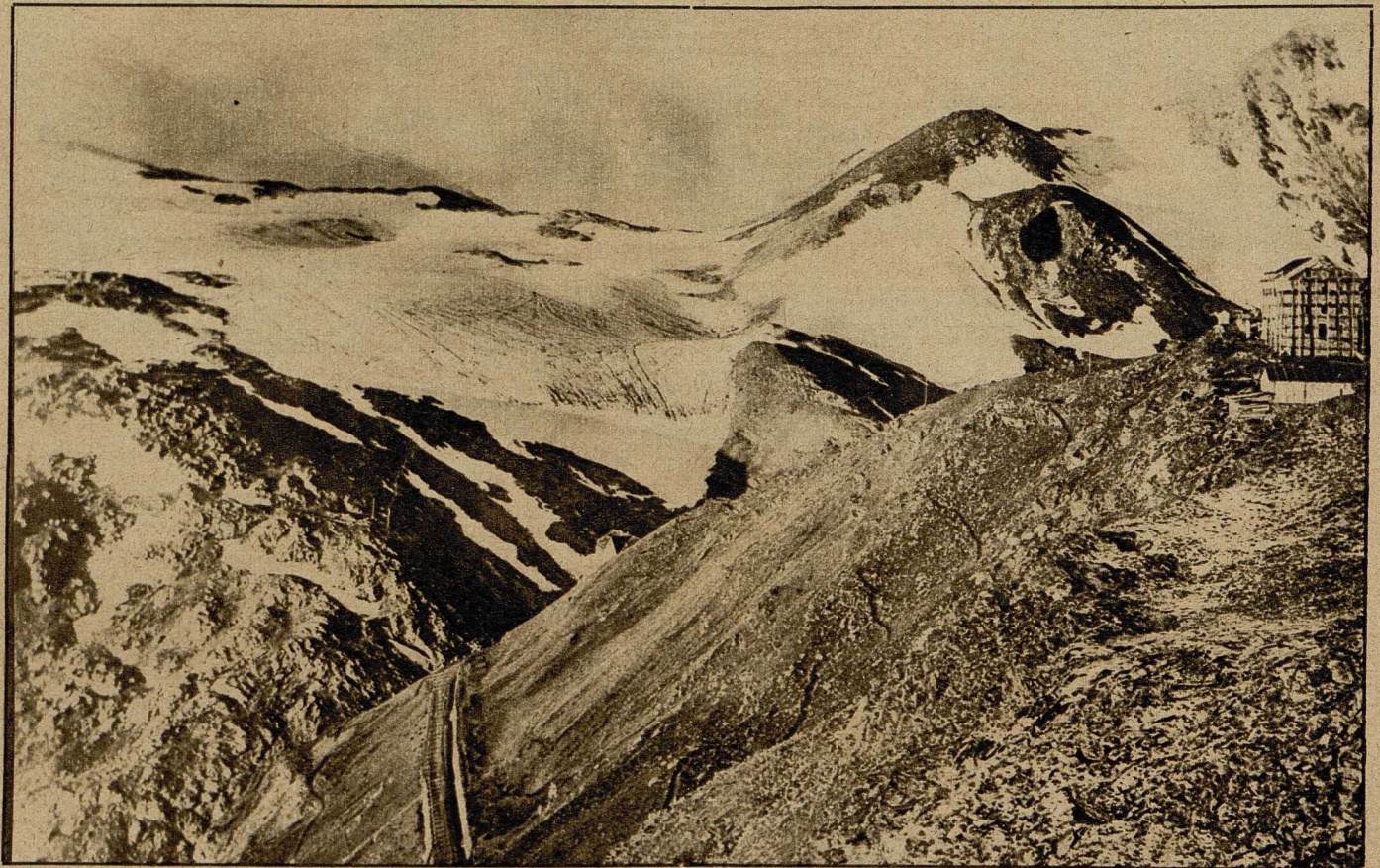
Vom italienischen Kriegsschauplatz. Die letzten Serpentinien der Stilfserjochstraße mit dem Schutzhause „Ferdinandshöhe“, welche die Italiener seit Wochen vergeblich zu erstürmen versuchen. (An dieser Stelle stoßen die drei Grenzen von Oesterreich, Italien und der Schweiz zusammen.)
