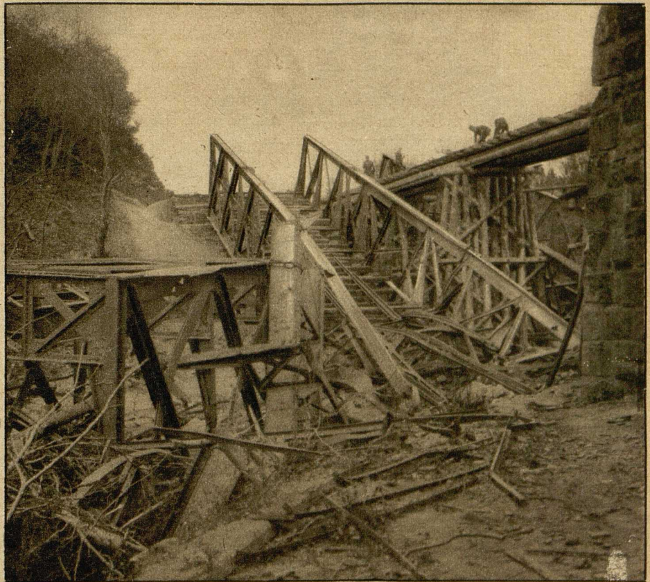
Die zerstörte Dslawica-Brücke vor Kamancza, durch deren Sprengung die Russen den Siegeszug der verbündeten Armeen aufzuhalten gedachten. Die Pioniere überbrückten den Dslawicafluß mit einem Pfahlbau, der in kürzester Zeit das Passieren ermöglichte. (Phot. Sennecke.)
