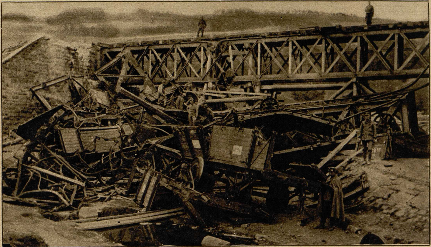
Ein bei der überhasteten Flucht der Russen verunglückter Eisenbahnzug im oberen Sangebiet. (Phot. R. Sennecke.)
