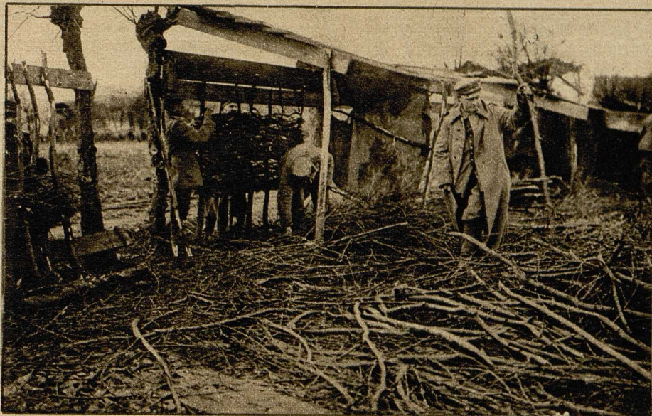
Arbeiten in einem deutschen Pionierpark hinter der Front: Anfertigung von Hürden für die Schützengräben.
