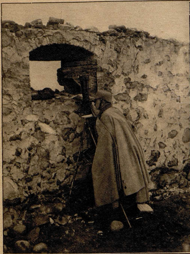
Artillerieoffizier am Scheerenfernrohr auf dem Beobachtungsposten an der Dachlücke eines zerstörten Hauses.
