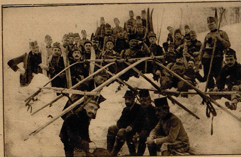
Wie eine Hütte im Schnee erbaut wird: Als Träger für die Zeltbahnen dienen Skier und Stöcke.
