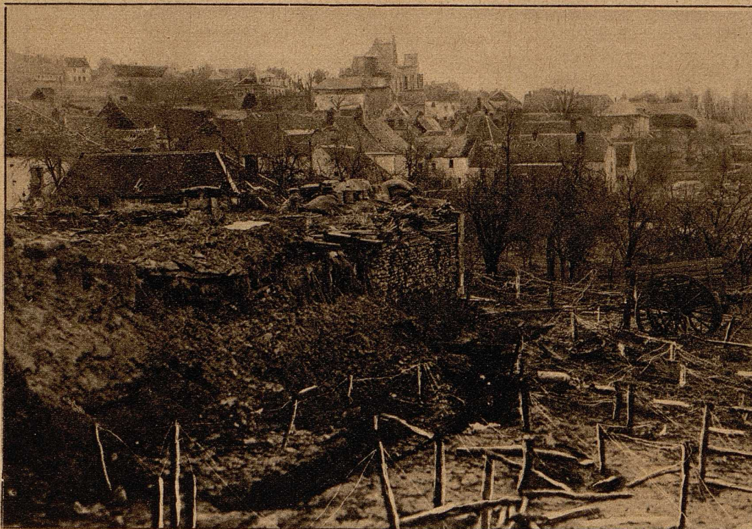
Die Stadt Craonne mit den Höhen, die von unseren Truppen im Sturm genommen wurden. Im Vordergrund die zahlreichen Hindernisse und Drahtverhaue. (Phot. A. Grohs.)
