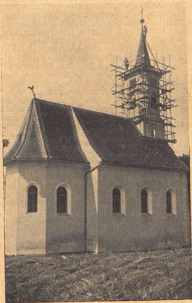
Die schmucke Hauskapelle mit dem eingerüsteten Turm
