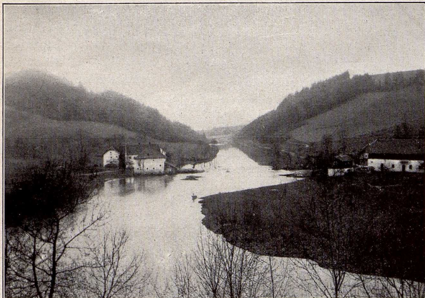
Bild 15. Becken von Purgstall bei höherem Wasserstand, Blick gegen W.
