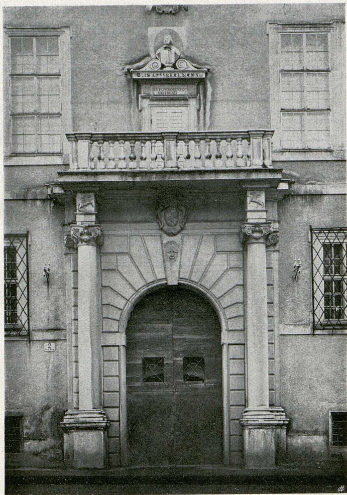
Stift St. Peter Portal der Domplatzfassade
