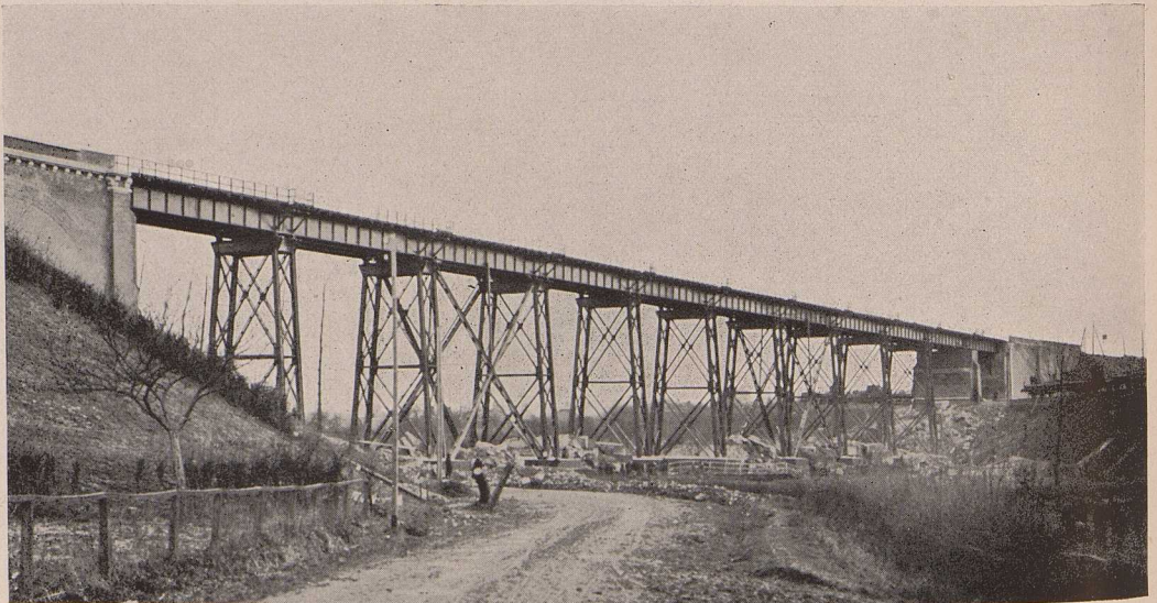
Bild 13. Die zweigleisig wiederhergestellte Brücke bei Dhis. (Zu Seite 73.)
