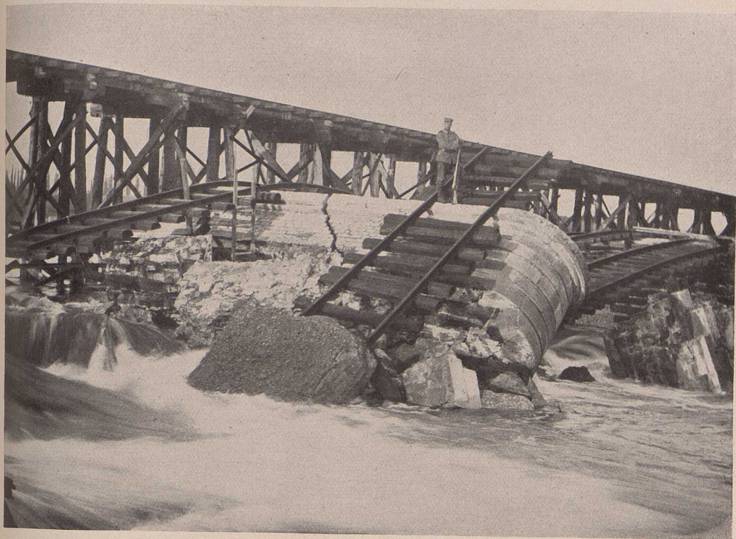
Bild 1. Brücke über die Maas bei Donchery. (Zu Seite 67.)
