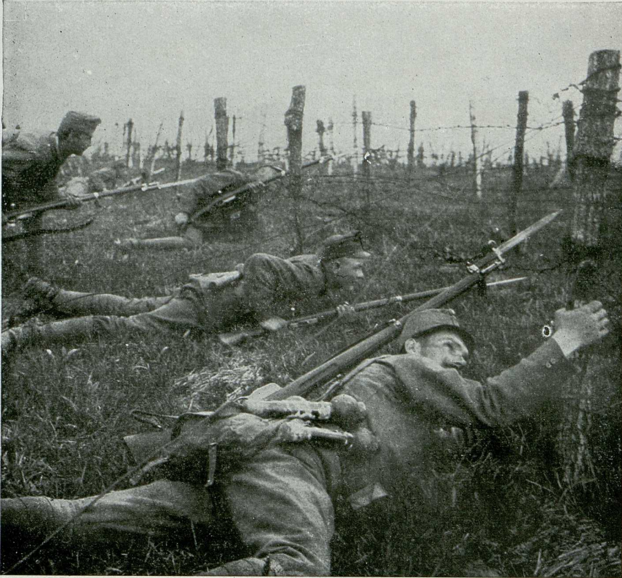
Beseitigung von Drahthindernissen.
