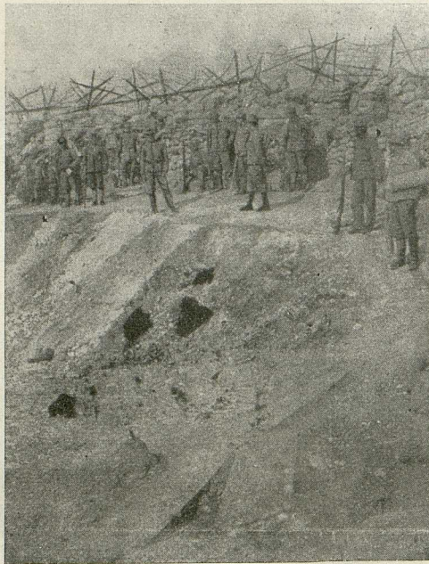
Technische Verstärkung des Trichters. A megerősített tölcser.
