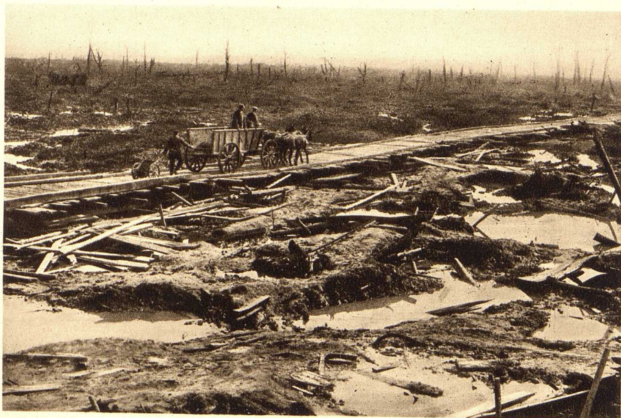
Im Npernbogen. Kampfgelände vor Hollebefe. Ein Wagenverkehr ist nur auf von Pionieren angelegten Bohlenwegen möglich.
