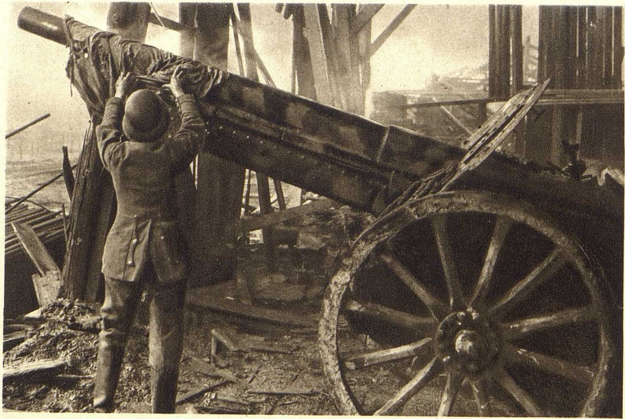
Das durch schnelle Schußfolge heißgewordene Rohr wird durch Auflegen feuchter Lappen gekühlt.
