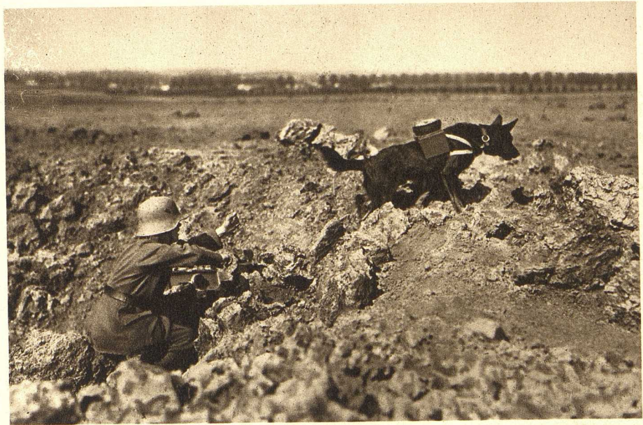
Ein Meldehund beim Legen einer Fernsprechleitung. Auf dem Rücken des Hundes ist die Drahtrolle befestigt.
